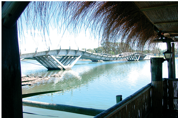
Brücke von La Barra
